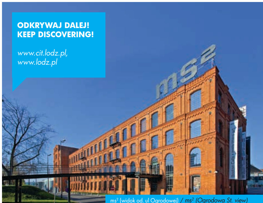
ms 2 (widok od ul. Ogrodowej) / ms 2 (Ogrodowa St. view)
