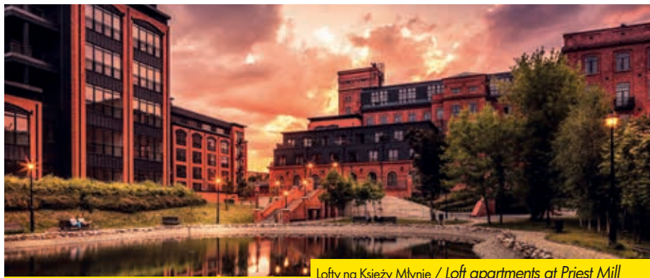
Lofty na Księży Młynie / Loft apartments at Priest Mill
