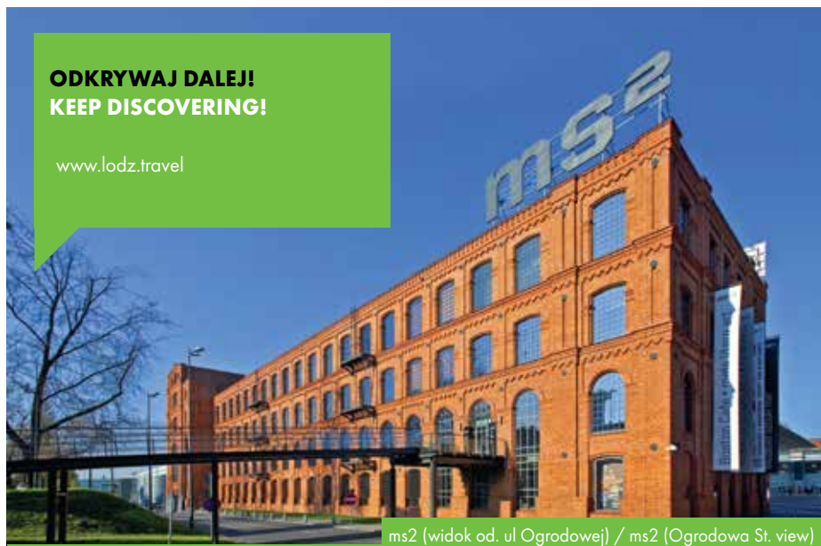
ms2 (widok od. ul Ogrodowej) / ms2 (Ogrodowa St. view)
